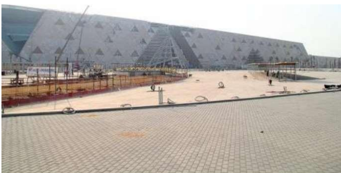
Photo du Chantier 2019
